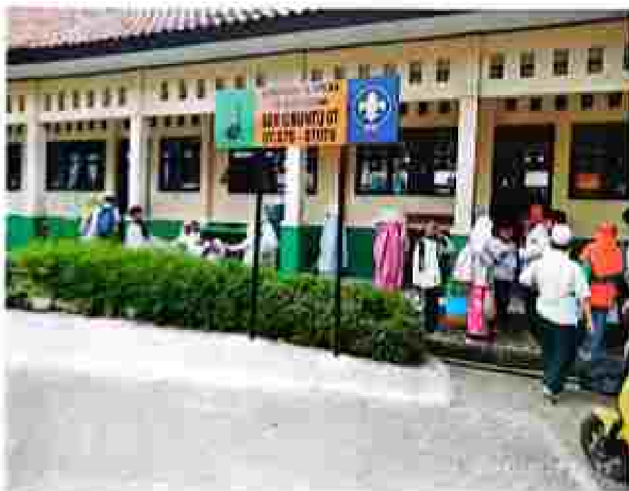
GEDUNG SEKOLAH : KELAS 3,4, 5 DAN PERPUSTAKAAN
